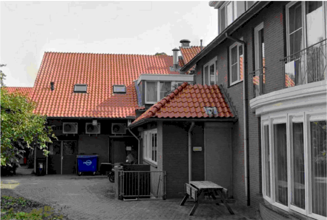
Afbeelding 2.2 Foto's bestaande afzuiginstallatie
