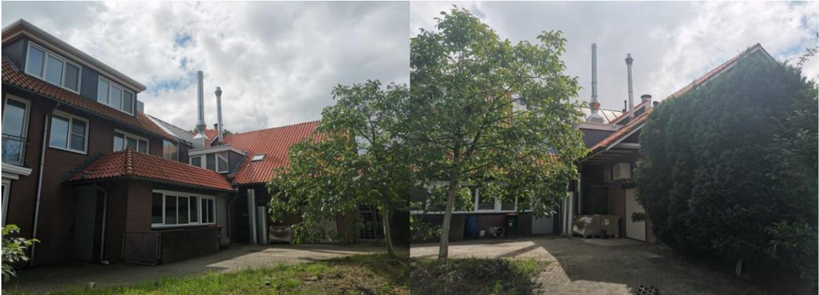
Afbeelding 2.2 Foto's huidige afzuiginstallatie
