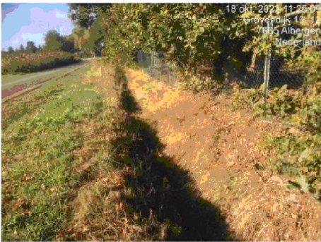
Sloot gravendijk/kruising Braakvenweg
