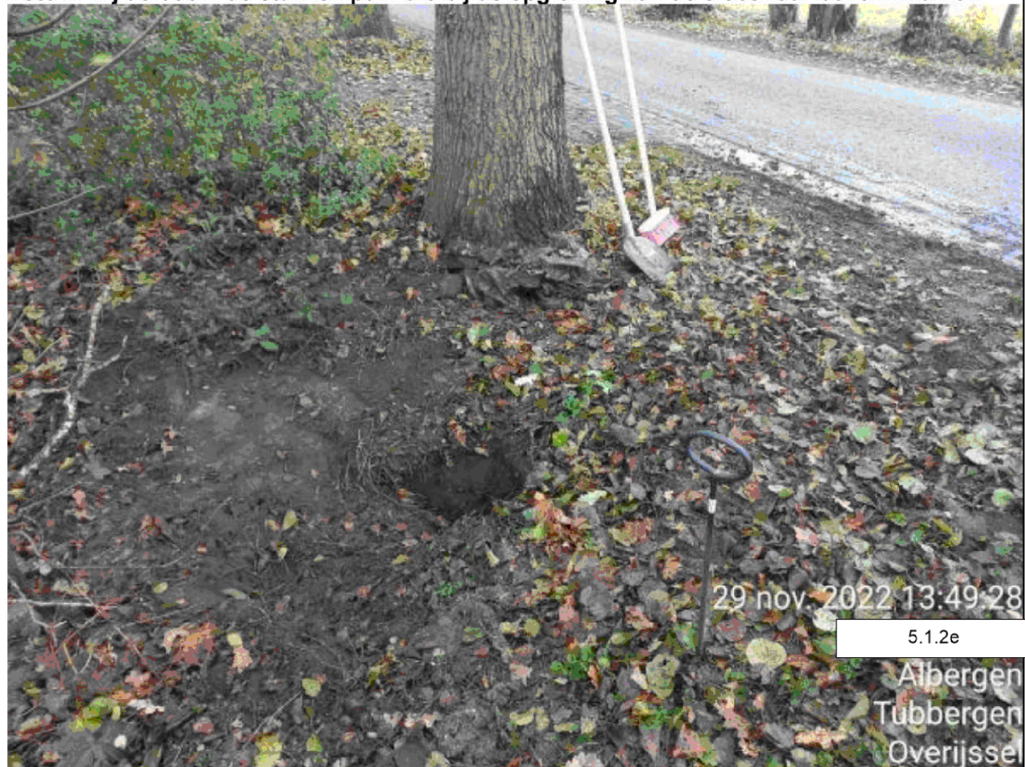
Foto 2: Bij de boom de stukken puin die bij de opgraving van de sloot naar boven kwamen
