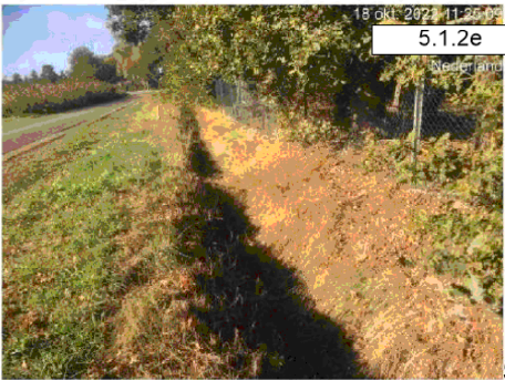
Sloot gravendijk/kruising Braakvenweg
