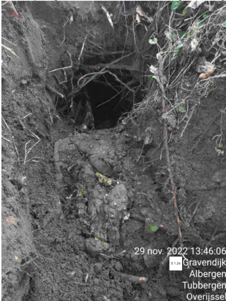
Foto 3: Opening van duiker andere kant van de weg t.o.v. lozingspunt
