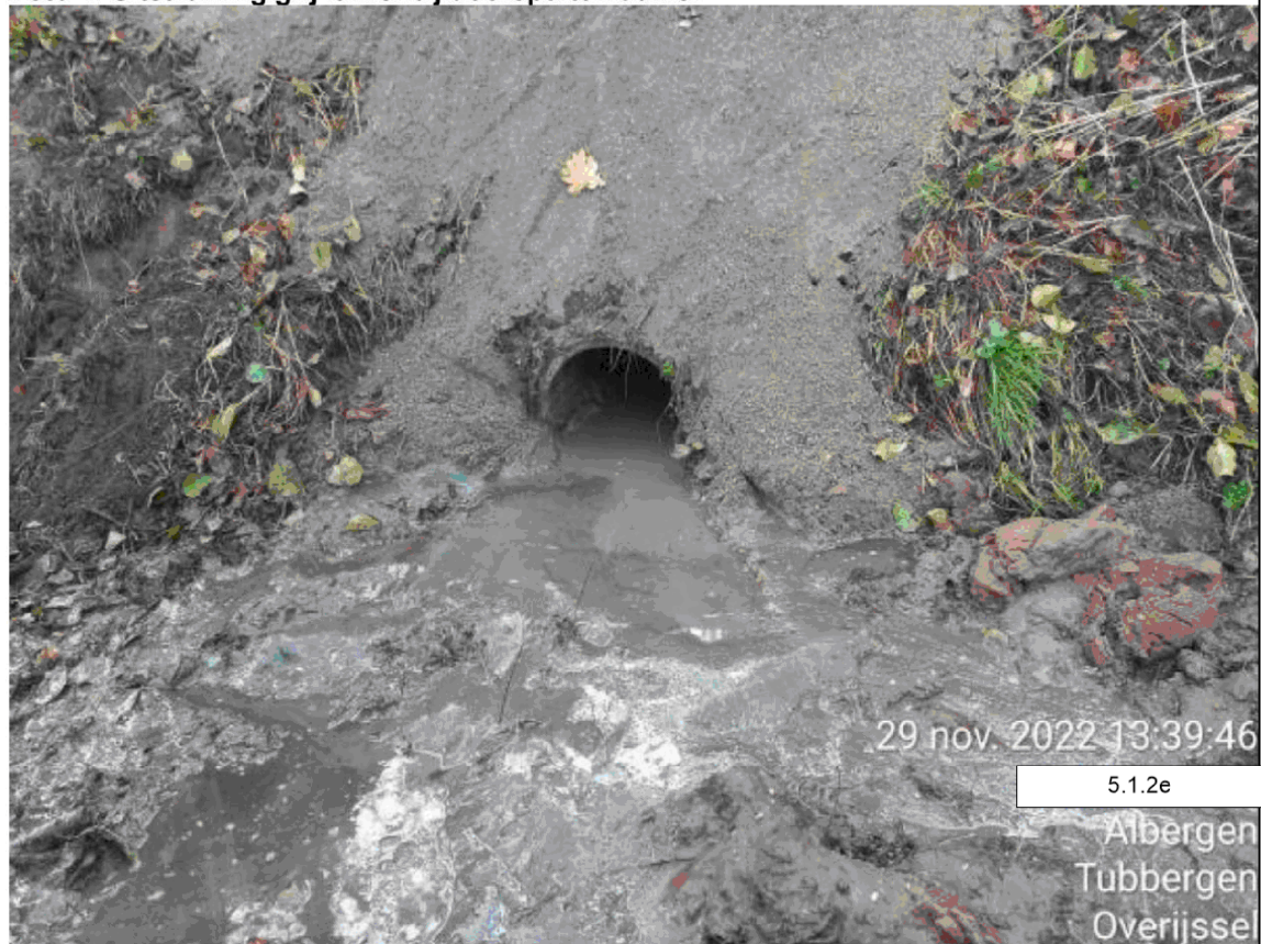
Foto 4: Uitstroming grijze klei bij doorspuiten duiker
